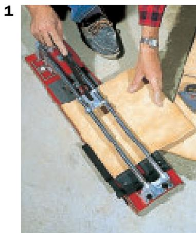
**1. Le carreau bien positionné sur la table de la machine à couper, pousser en un seul geste le chariot en maintenant la molette en appui sur le carreau.**
