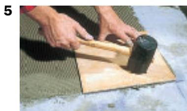
**5. Tapoter le carreau avec un maillet en caoutchouc pour l'ancrer dans le mortier-colle.**
