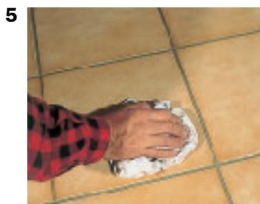
**5. Terminer en frottant avec un chiffon sec qui éliminera toutes les traces de mortier à joints sur les carreaux. Après séchage complet, 48 h plus tard, on peut laver le sol.**
