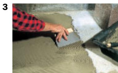
**3. Réaliser des sillons dans l'épaisseur du mortier-colle avec la spatule dentée, afin de permettre un bon ancrage des carreaux.**
